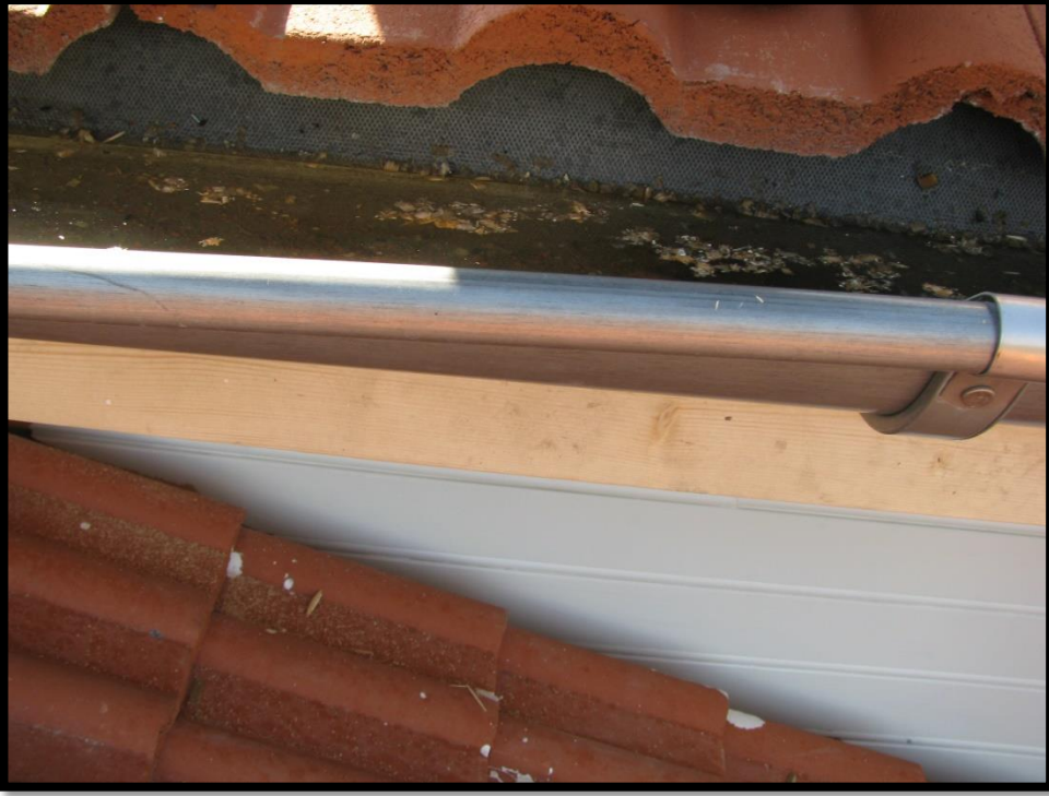
İmalat öncesi çatı örtüsünde kullanılacak malzemelerin ve gizli oluk kesitinin numune amaçlı yapımı
