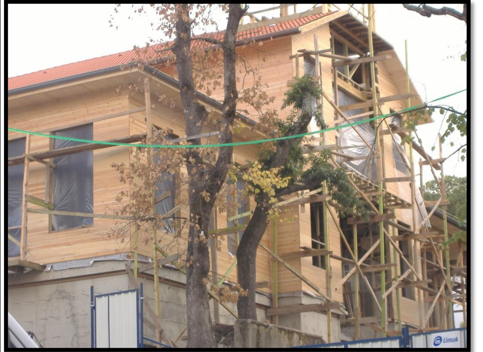
Dupont-Tyvek Nem İzolasyon Malzemesi-Yalı Baskı Altından Görünüş
