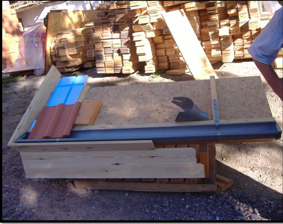
İmalat öncesi çatı örtüsünde kullanılacak malzemelerin ve gizli oluk kesitinin numune amaçlı yapımı
