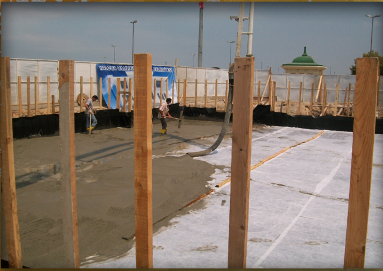
TEMELDE DÖŞEME BETONU
