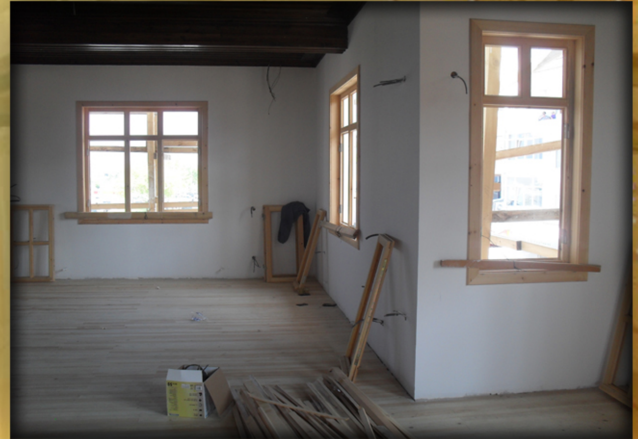
İÇ CEPHE BOYA
