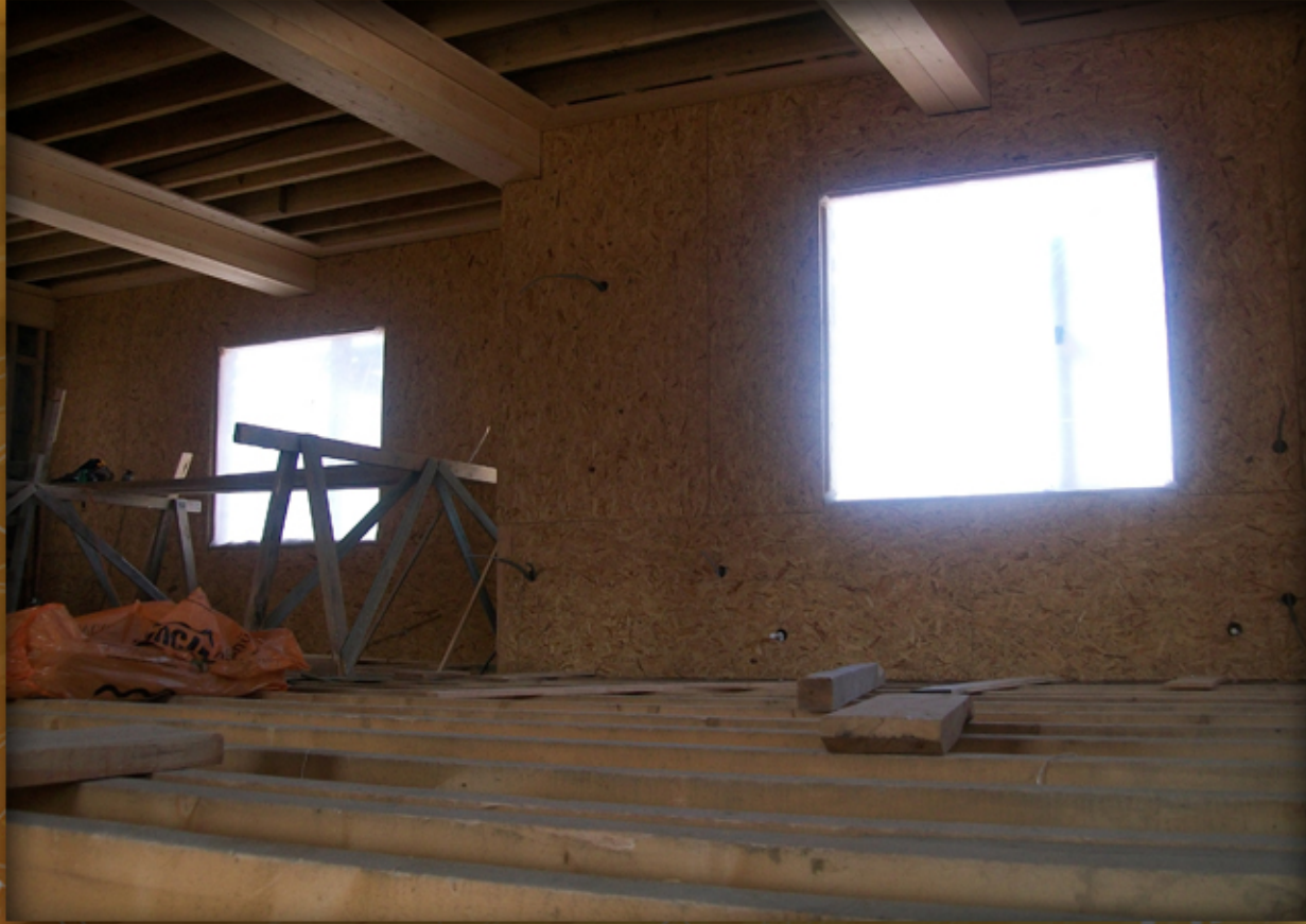
DUVAR OSB KAPLAMA
