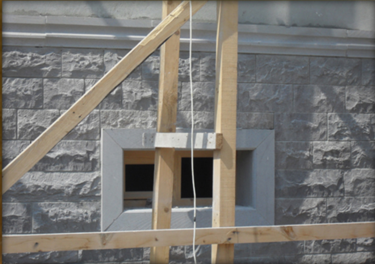
DIŞ CEPHE TAŞ KAPLAMA
