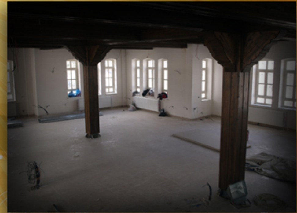
ZEMİN KAT SON DURUMU
